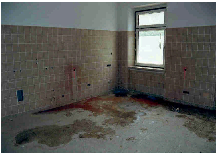
Bild 1: Ehemalige Zahnarztpraxis vor der Sanierung
