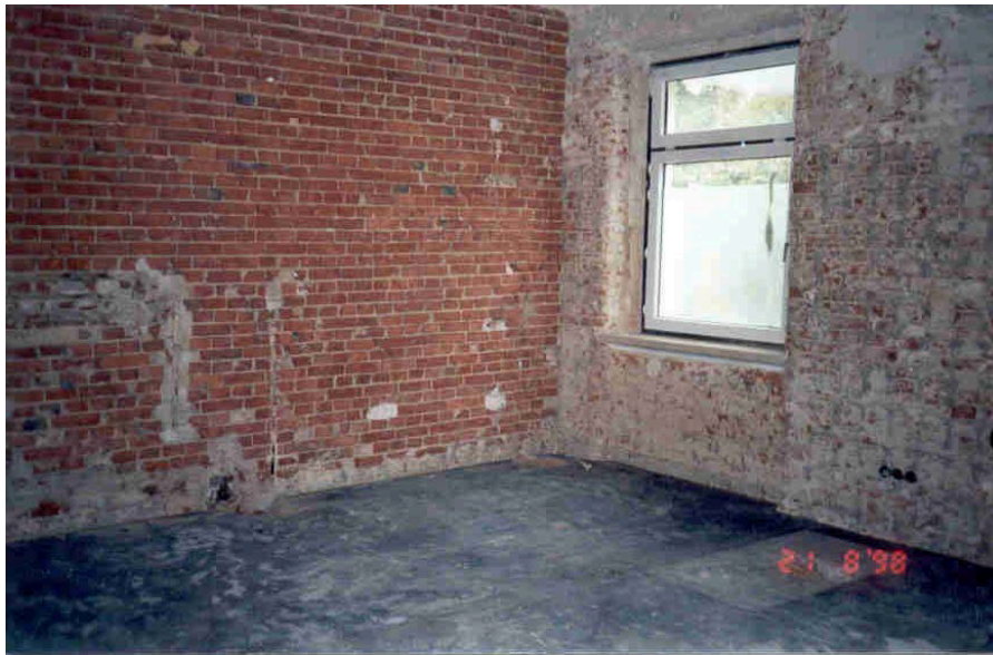
Bild 2: Ehemalige Zahnarztpraxis nach der Sanierung
