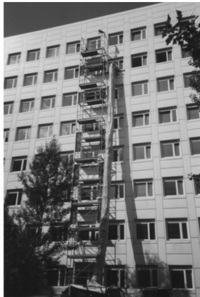
Foto 1: Haus A während der Sanierung
