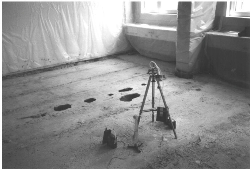
Foto 2: Raum A 720, Parallelmessung am 20.06.2003, links die Wand zur Nasszelle mit der angeschnittenen Teerpappe
