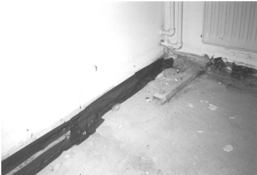
Foto 3: Raum A 720, 25.06.2003, links die Wand zur Nasszelle mit abgeklebter Teerpappe - Schnittkante, rechts Teeranstrichreste
